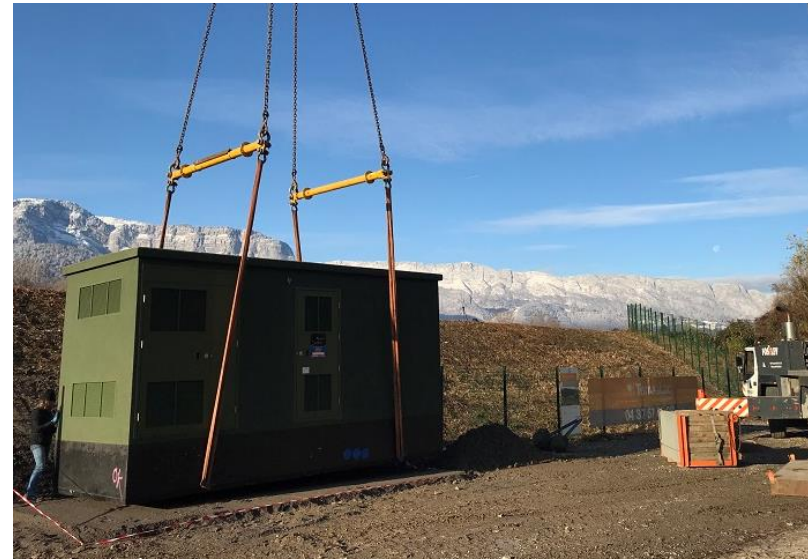
Modèle de local technique intégrant le poste de livraison
