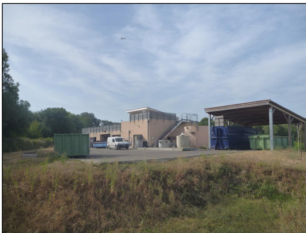
Figure 19 : Vue d'ensemble de la station d'épuration
