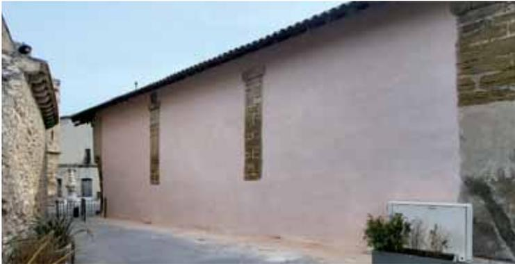
**Halle couverte.** Avec le temps, même les meilleurs enduits finissent par s'altérer. Ainsi, le mur extérieur est de nouveau protégé par un enduit à la chaux, taloché à l'ancienne.
